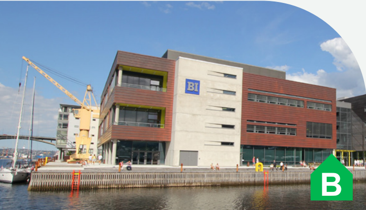
BI-bygget – Undervisning og kontor | 7.000 m²
