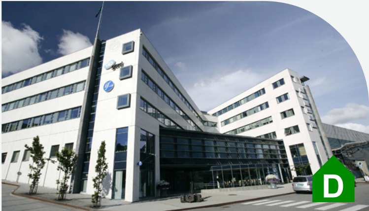
Skipsbyggerhallen – Kontorbygg | 12 200 kvm
